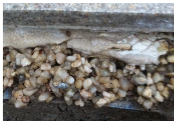
Figur 8: Eksempel på rundkornet dreneringsmørtel med epoksy bindemiddel
