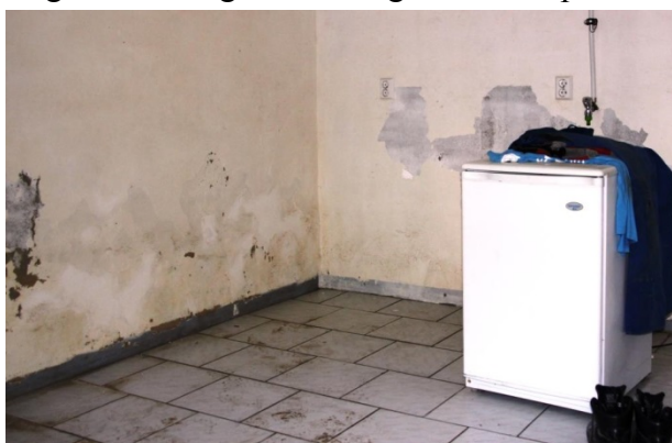
Figur 2: Løs puss er et symptom på fuktvandring i veggen som må tettes fra utsiden
